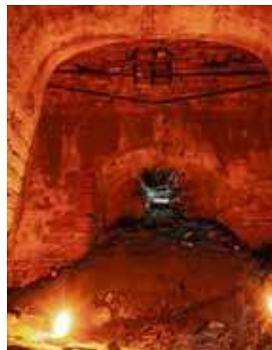
Im Historischen Glaskeller ist noch dieser Ofen bei Eisenbach erhalten.
