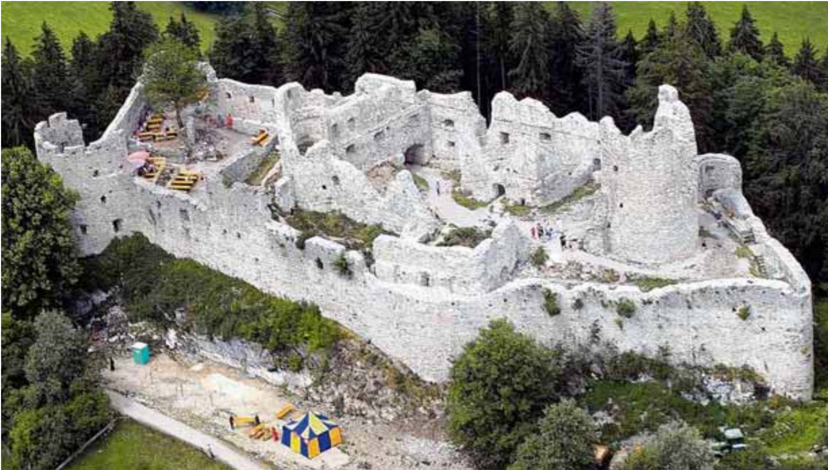
Auf einem Felsplateau hoch über dem Dörfchen Zell thront die Burgruine Hohenfreyberg. Das Luftbild entstand kurz nach Abschluss der wichtigsten Konservierungsmaßnahmen. Gut zu erkennen sind Artillerierondell (linker Bildrand) und Bergfried (der große Turm rechts im Bild). Foto: Helmut H. Kroiß
